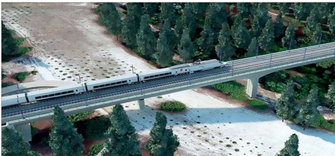
Viaducto sobre la Zona de Especial Conservación 'Riberas del Adaja y Afluentes', una de las estructuras que forman parte del proyecto. E. M.
